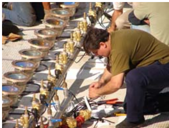
Cableados del Sistema de Iluminación y de la Válvulas de Impulsión y Alivio.
