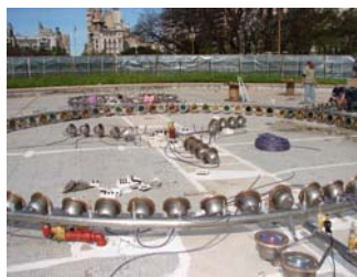
Cableados del Sistema de Iluminación y de la Válvulas de Impulsión y Alivio.
