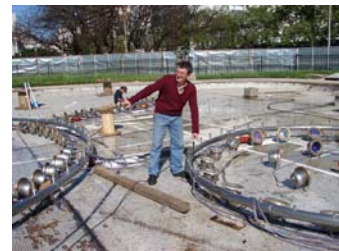
Cableados del Sistema de Iluminación y de la Válvulas de Impulsión y Alivio.
